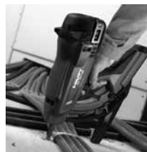
Tuberías y tuberías con cintas metálicas o textiles
