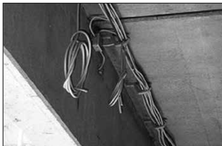
X-ECH para fijar manojos de cables
